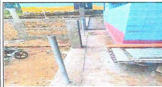
Foto 5: Construcción de muro frente de la escuela.
