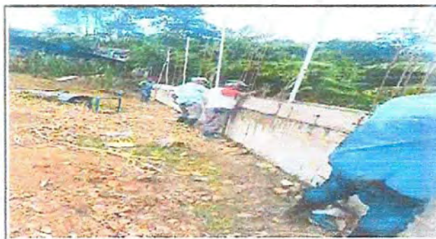
Foto 4: Colocación de tubos para mayas y blocks a muro.
