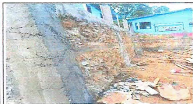
Foto 3: Construcción de muro frente de la cocina.
