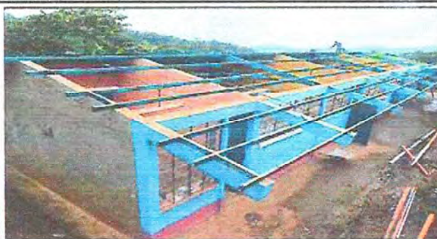
Foto 1: Limpieza y pintura de las costaneras.
