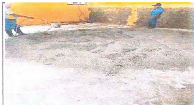
Foto 6: Cambio de piso con torta de cemento.
